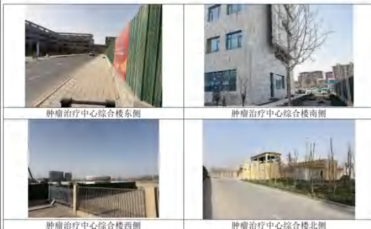
图 8.1-1 项目场址现状图
