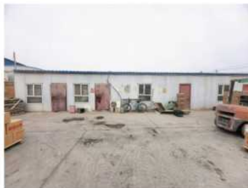
项目厂区宿舍楼
