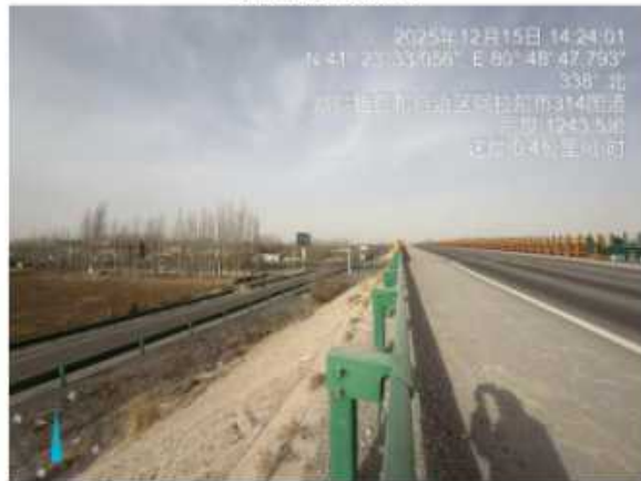
现场踏勘照片
