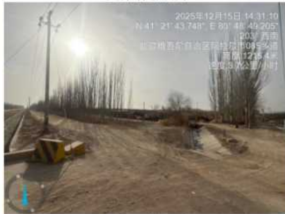
现场踏勘照片
