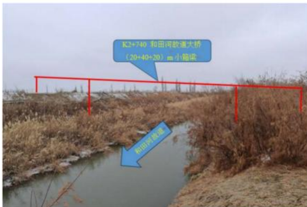
图 3.2-13 和田河故道大桥桥位图
