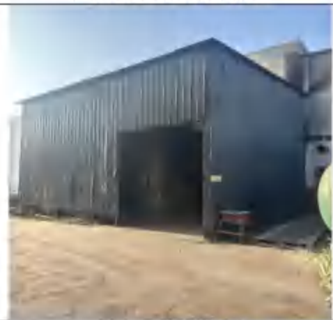
厂外生物质锅炉
