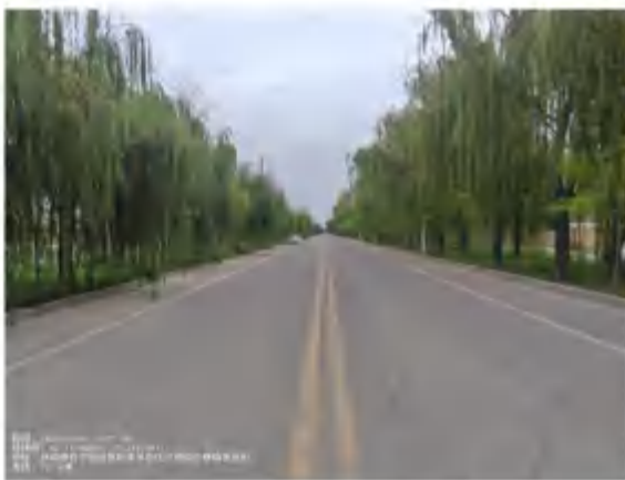
项目北侧（永宁路）
