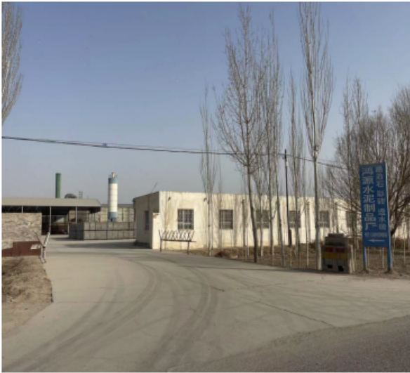
厂区南侧水泥加工企业
