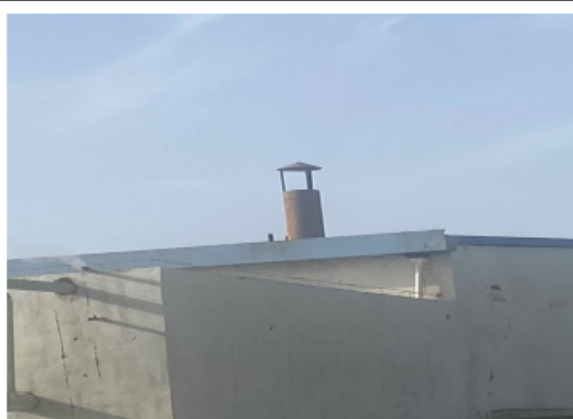
锅炉房排气筒 (DA002)
