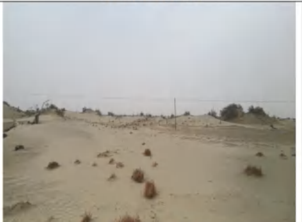
暂存池建设位置
