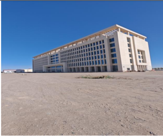
项目区现状楼
