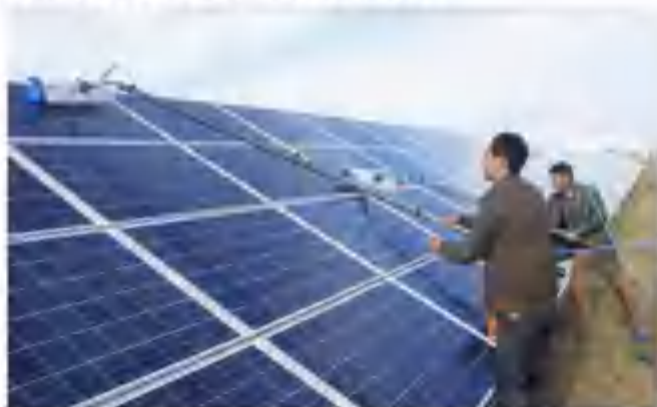
图 2-1 光伏组件清洗示意图
