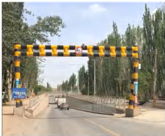
兴业路起点现状
