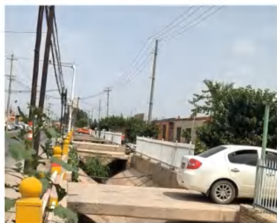
兴业路终点路段乌尊支渠现状
