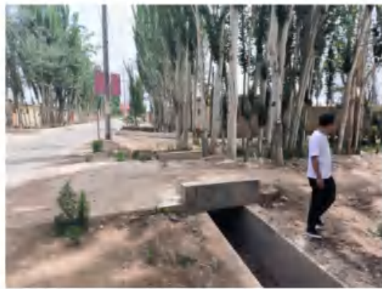
安业路塔格其村渠道
