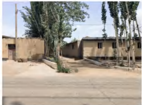
安业路终点现状
